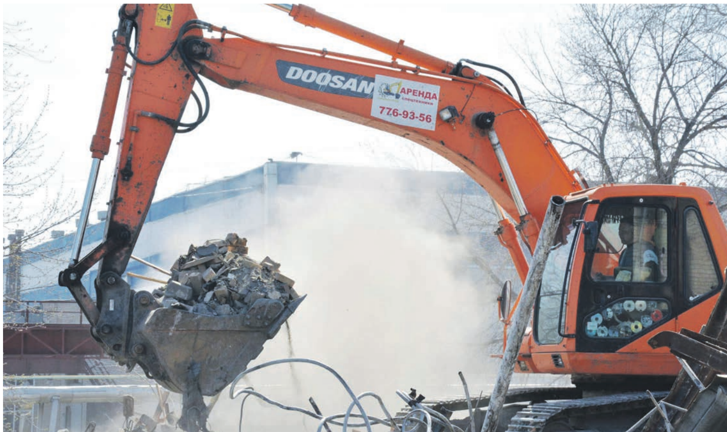
△ Дорогу строит подрядчик «Трубодетали» – предприятие «Архитек» © МАКСИМ КУЛИКОВ
